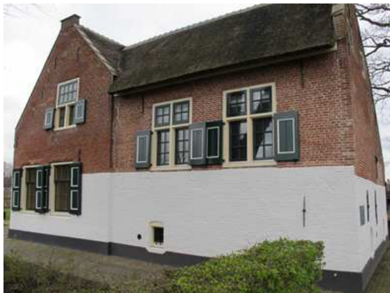
Een van de korte kanten van de boerderij met de opkamer boven het raampje van de melkkelder (foto: Wim van Horssen).
